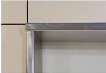
Откосы из нержавеющей стали. Облицовка фасада – керамогранит
