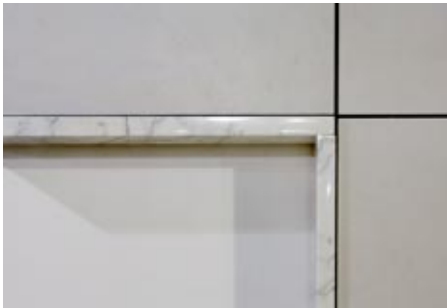
Откосы из мраморных слэбов. Облицовка фасада – керамогранит
