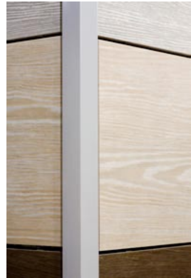
Оформление стыка плит на внешнем углу окрашенным алюминиевым молдингом
