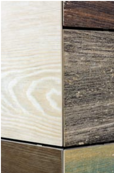
Примыкание плит на внешнем углу с подрезкой на ус под 45°
