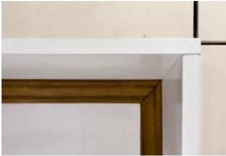
Откосы из окрашенной оцинкованной стали. Облицовка фасада – керамогранит
