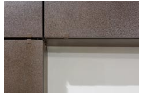
Откосы и облицовка фасада из керамогранита
